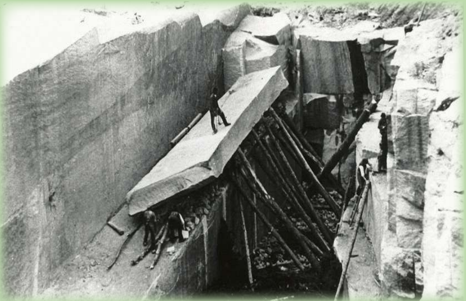
26 Steinbrecher bei der Arbeit. Der Block wird im Ganzen benötigt.
