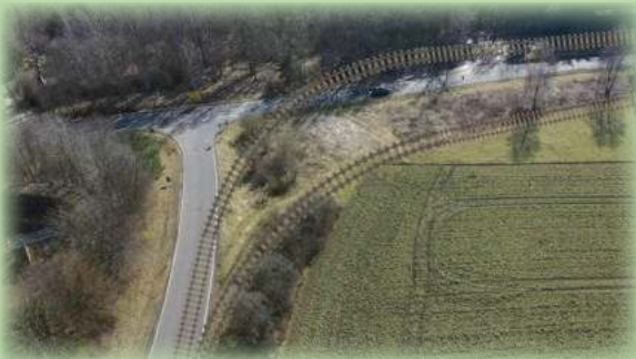
10 Linker Gleisstrang zum Güterbahnhof, dabei wurde die Straße nach Wehr/Rieden gekreuzt. Rechter Gleisstrang führte nach Weibern.
