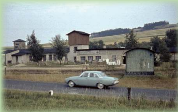
13 Güterbahnhof Weibern 1974. Werk der Firma TUBAG. Das blaue Wartehäuschen (Wellblech-Büddchen) war für die Reisenden aus Rieden.
