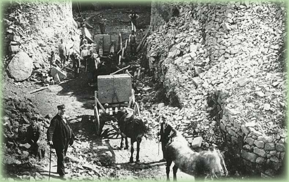
27 Rohlinge werden mit dem Pferdefuhrwerk aus dem Steinbruch gefahren.
